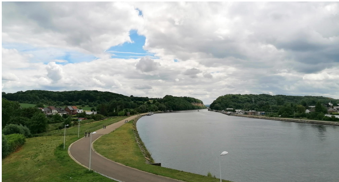
Fig. 1 : Vue du canal Albert et de la tranchée de la Montagne Saint-Pierre, reliant la vallée de la Meuse à celle du Geer. À droite, la colline où se trouve le fort d'Eben-Emael (Photo Ch. Caravello).
